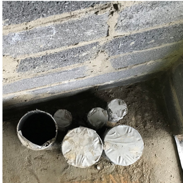
Străpungeri cu mânunchi de conducte în pardoseală care nu pot fi etanșate individual
