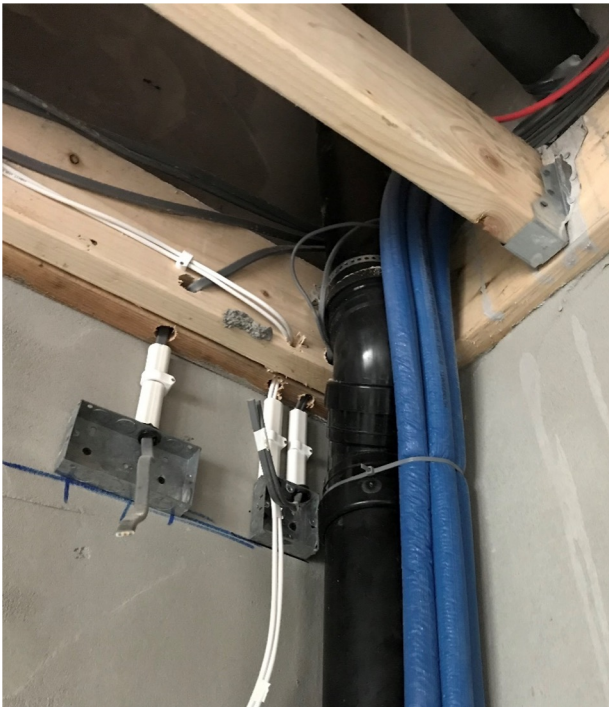
Străpungeri cu mânunchi de conducte răsucite amplasate foarte aproape în colțuri care nu pot fi îmbrăcate sau etanșate individual
