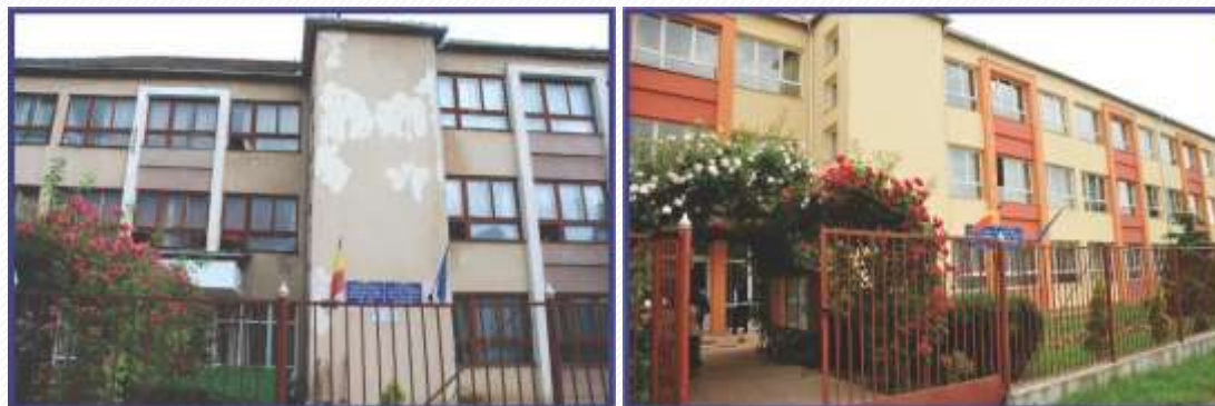
Eficiență energetică la Școala Bălcescu Petőfi
