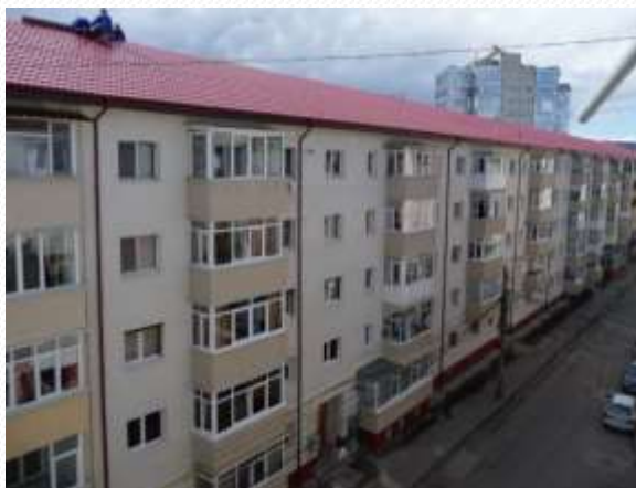
Reabilitarea termică a blocurilor
